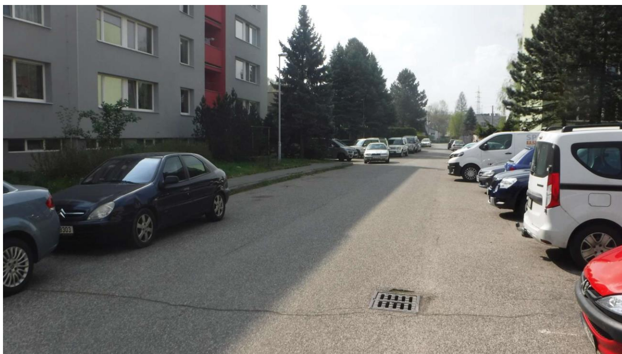
Obrázek 3 – Pohled na stávající parkovací plochy v ulici Papírenská
