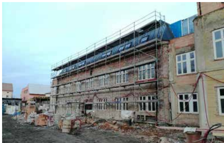
Celkový pohled na staveniště budovy
