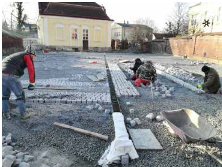
Pokládka žulové dlažby parkoviště
