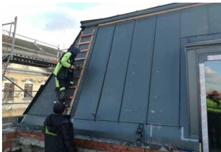
Klempířské práce na střeše budovy
